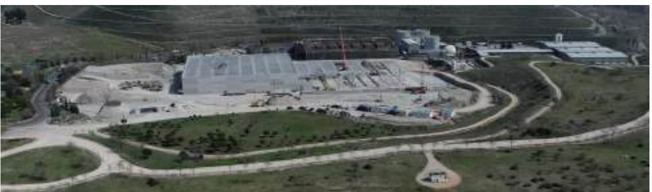
Avance de los trabajos de construcción
