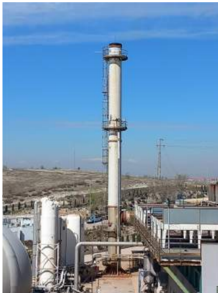
Chimenea de La Galiana.
