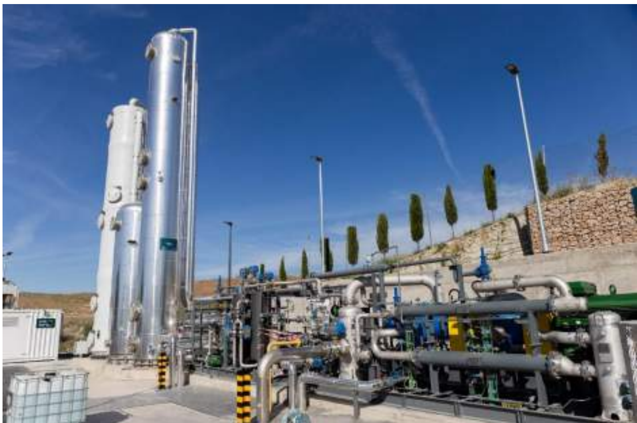
Ampliación de la planta de tratamiento de biogás
