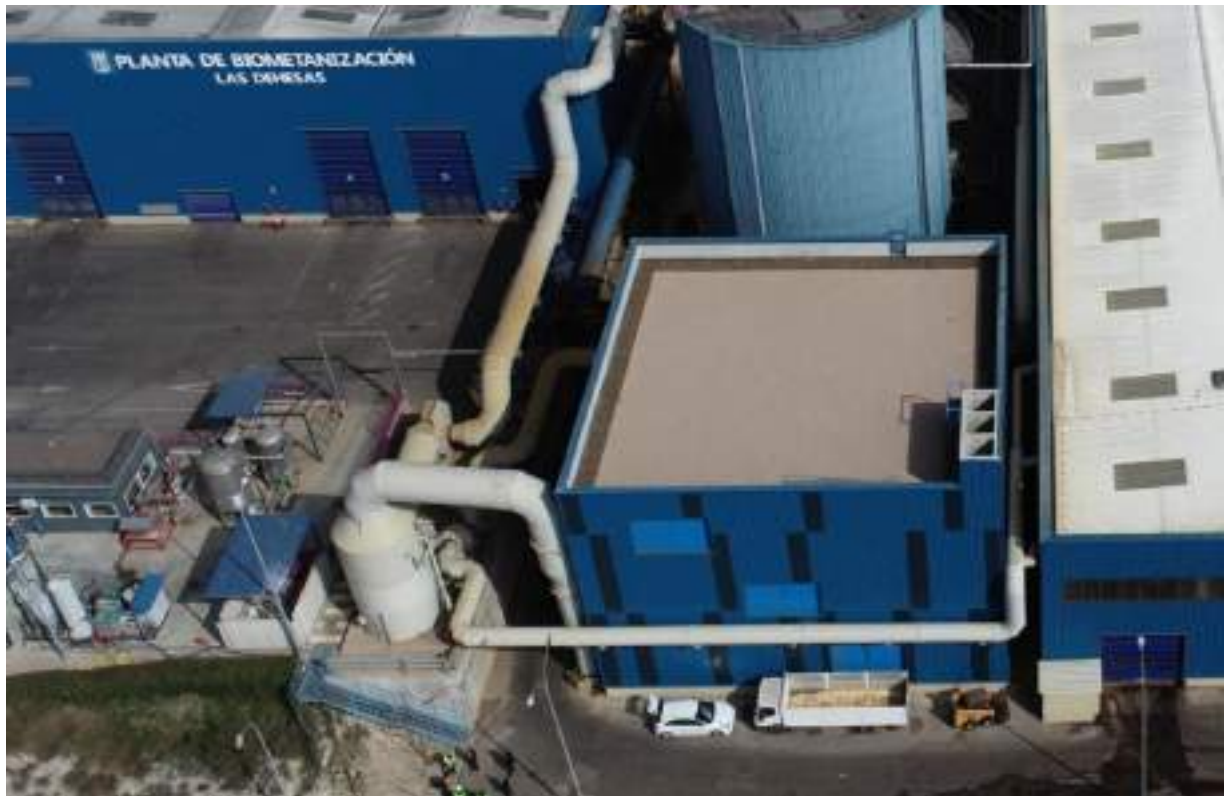
Sistema de desodorización (biofiltro avanzado) de la Planta de biometanización de Las Dehesas
